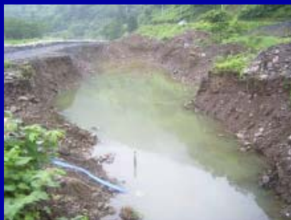
埋設物掘削後
