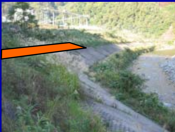
埋設物掘削前
