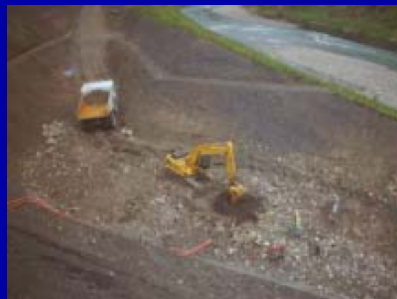
埋設物掘削後
