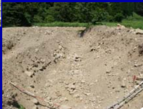
埋設物掘削後
