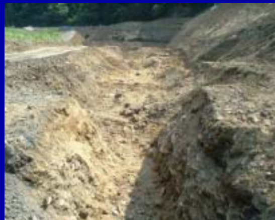
埋設物掘削後
