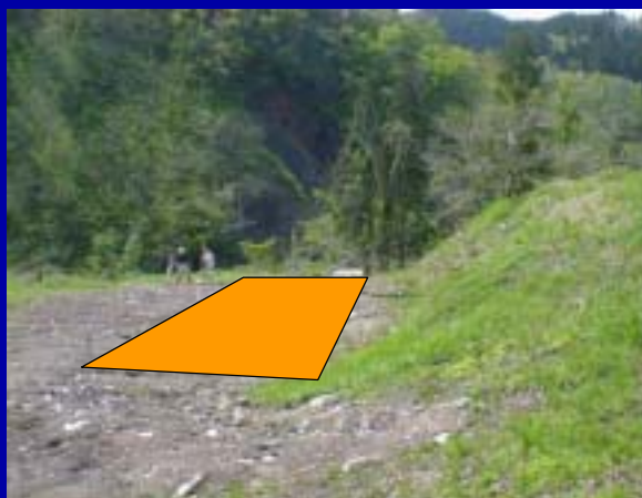
埋設物掘削前
