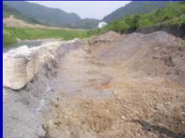
埋設物掘削後
