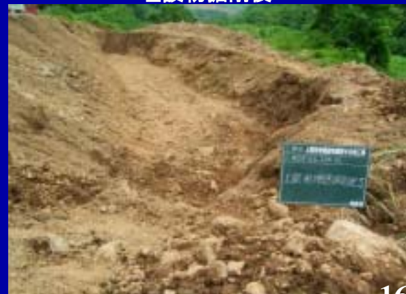
埋設物掘削後
