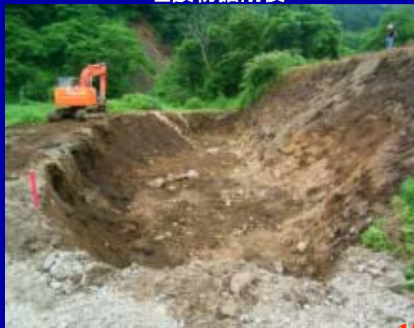
埋設物掘削後
