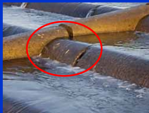
(河口から約5.0km付近:平成20年5月6日)
