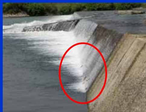
(河口から約5.5km付近:平成20年5月7日)
