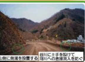
谷川に土手を設けて 山側に側溝を設置する 工事用道路の濁水対策
