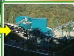
組み立て中の状態
