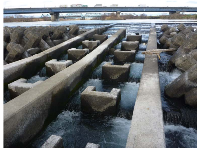
万石26m 3 /s時の第5床固魚道の通水状況 (H28.1.13撮影)
