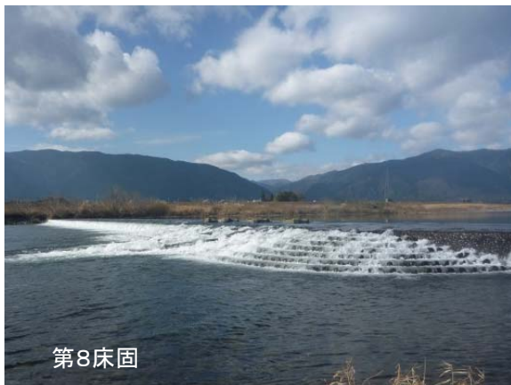
維持流量程度時(万石26m 3 /s)の床固の状況 (H28.1.13)
