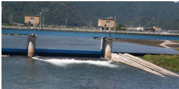
増量放流時の岡島頭首工の底部流出操作の状況 (H27.9.19)
