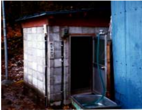
局舎全景（門入地点）
