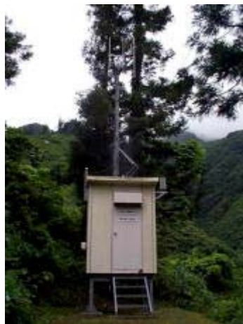
局舎全景（門入地点）
