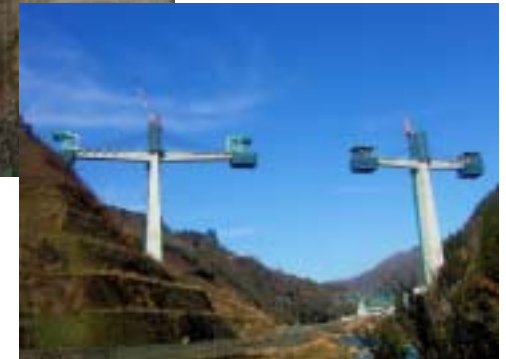
貯水池横断橋(6号橋)
