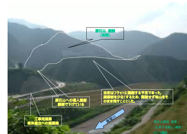
原石山掘削状況
