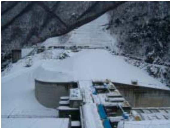
洪水吐きゲート部
