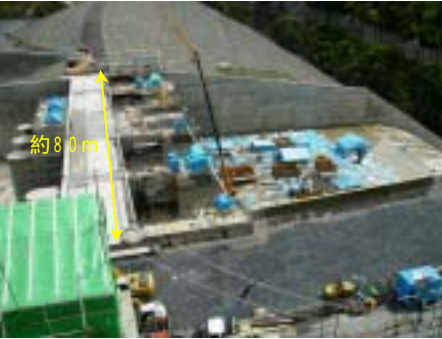
洪水吐き(越流部)
