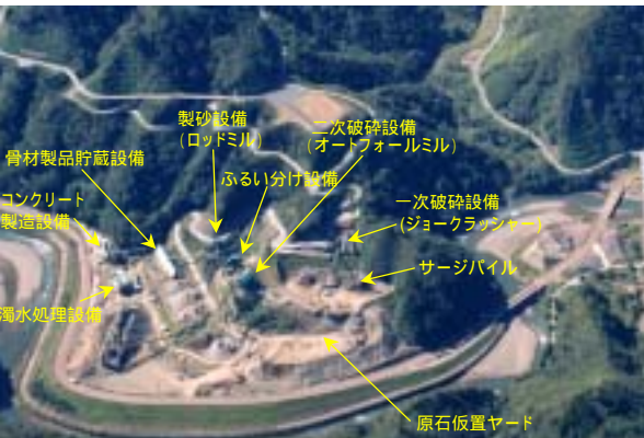
下開田プラントヤード (コンクリート製造設備)
