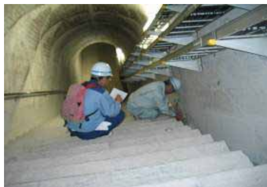
堤体監査廊内での計測
