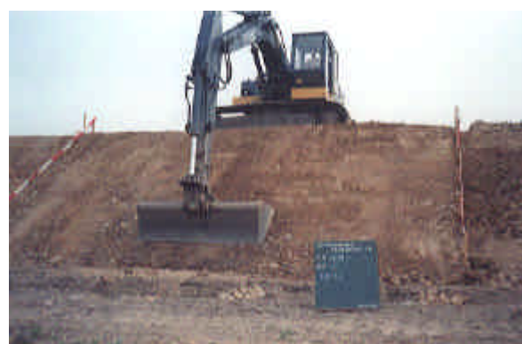
法面整形状況
