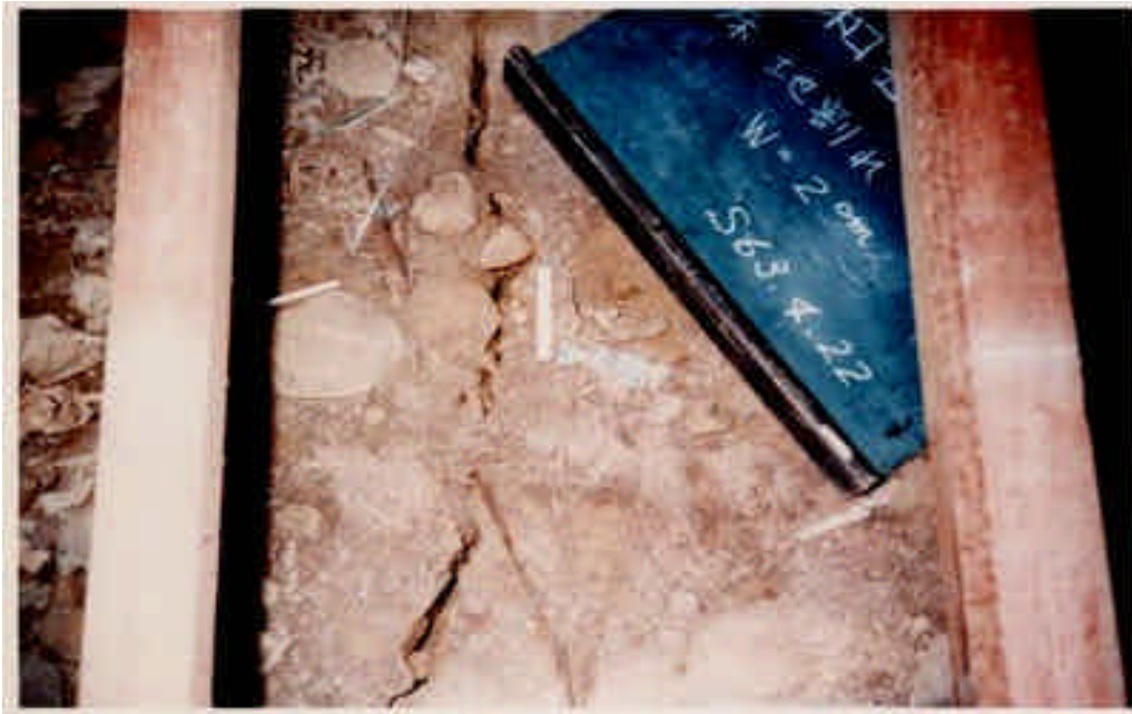
宅地地盤の損傷 昭和63年4月
