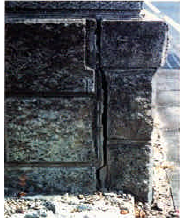
平成7年8月 壁の亀裂
