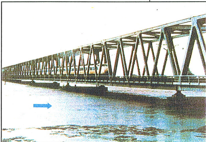
← 新幹線揖斐川橋の状況 (昭和50年8月)
