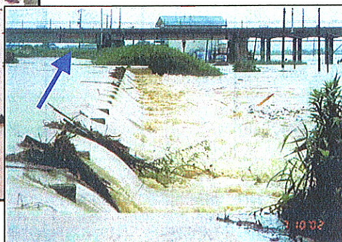
↑ 洗堰からの越水状況 (平成14年7月)
