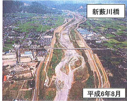
下流上空から上流方向を望む
