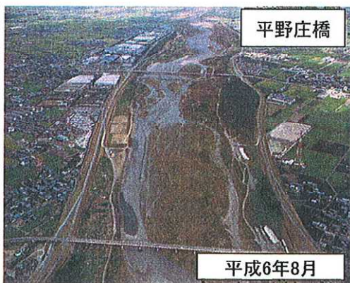
下流上空から上流方向を望む
