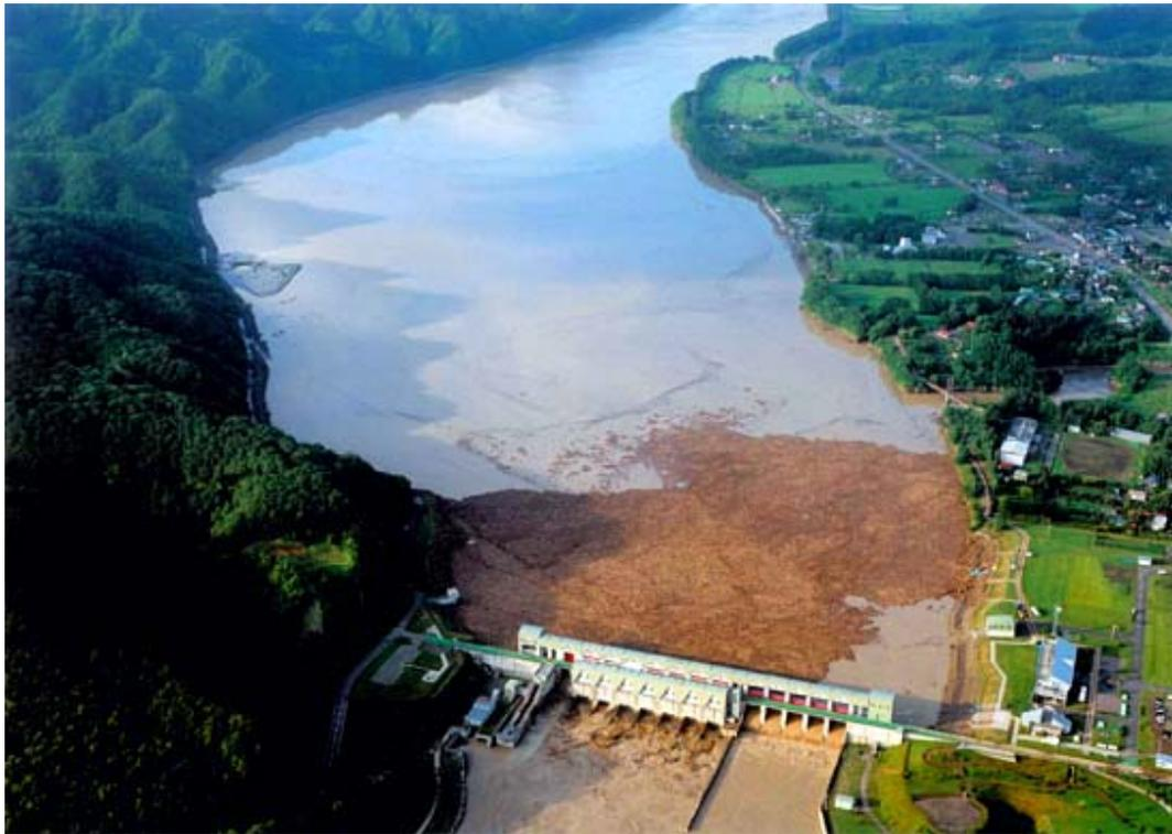
洪水の際、上流で流木が多数発生した。流木は、二風谷ダムに流れ込み、ダムは、約5万m<sup>3</sup>にも及ぶ大量の流木を捕捉する結果となった。
