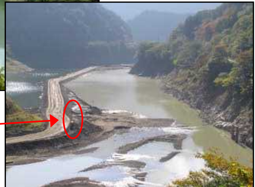
掘削中の状況(平成15年)
