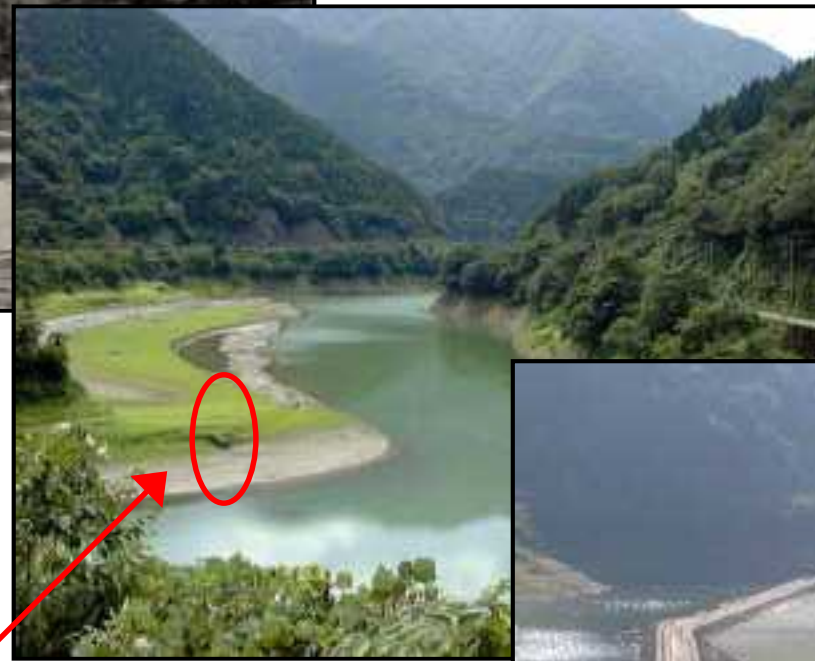
掘削前の状況(平成13年)
