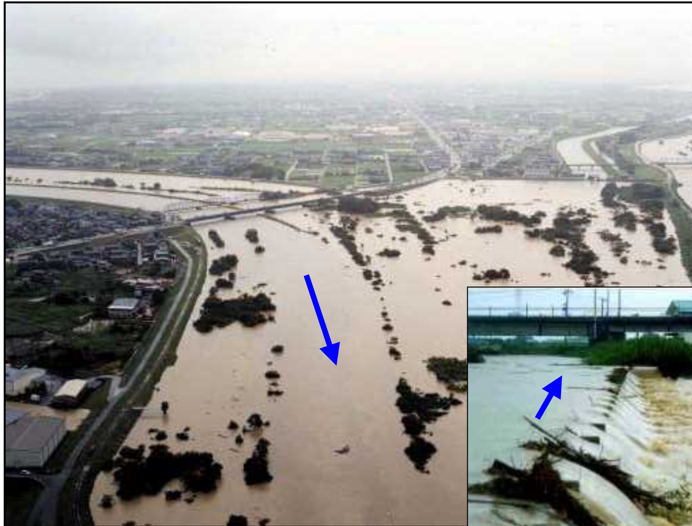
揖斐川・牧田川合流地点の状況(31. OK付近)
