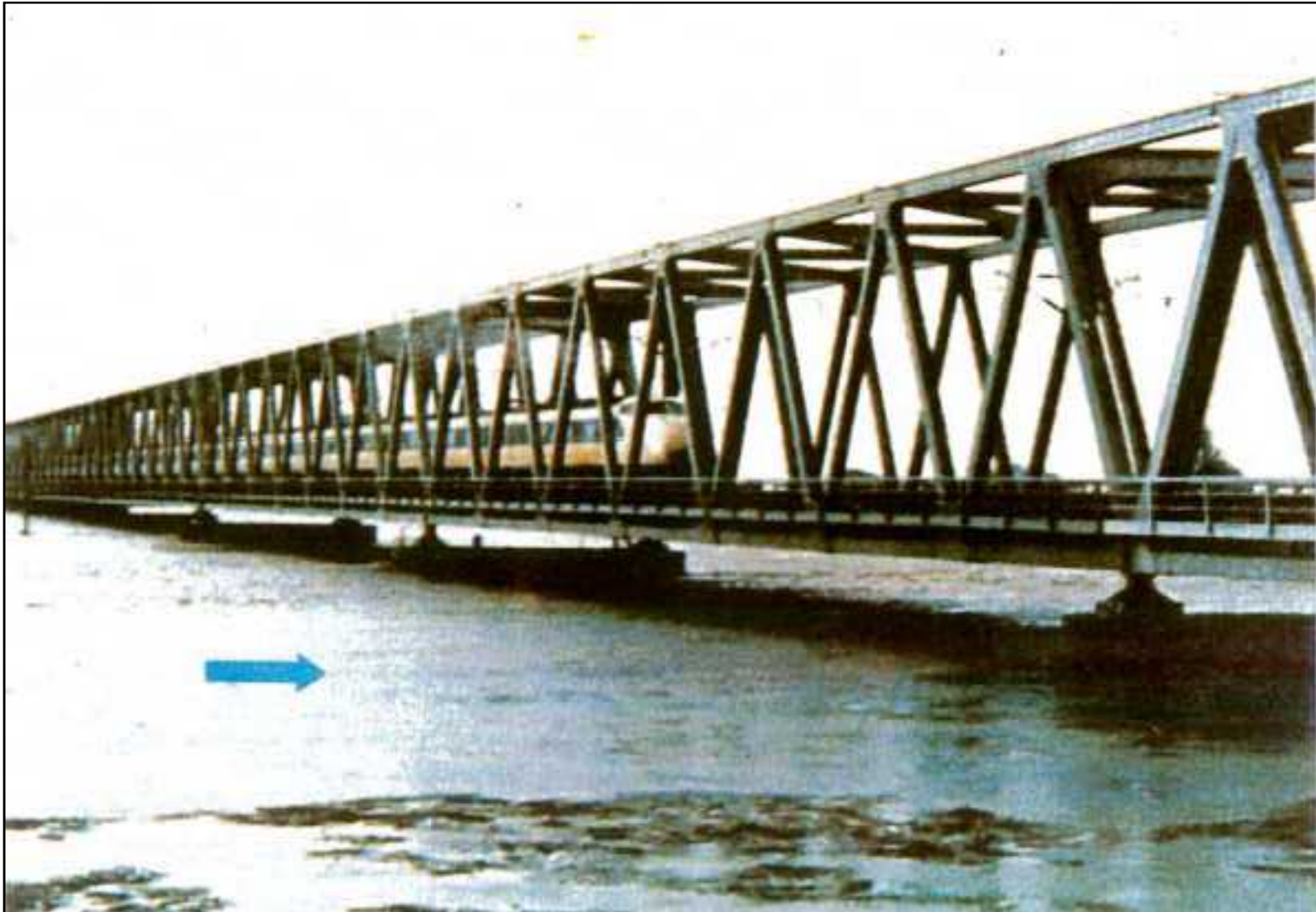
新幹線揖斐川橋(38. 2K付近)
