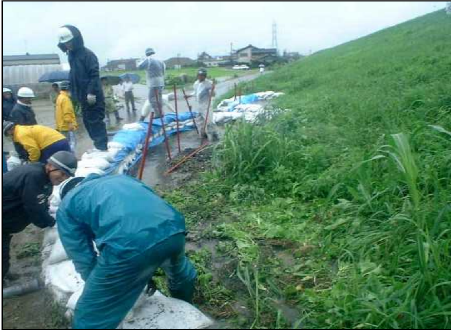
揖斐川右岸46. 6K付近の堤防裏の漏水対策のための水防状況
