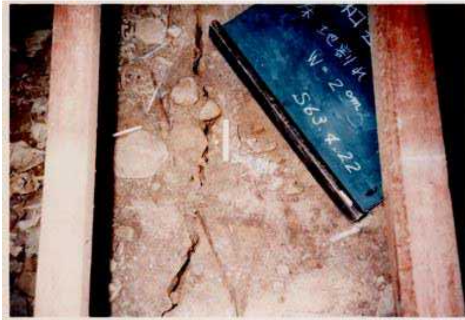
宅地地盤の損傷 昭和63年4月
