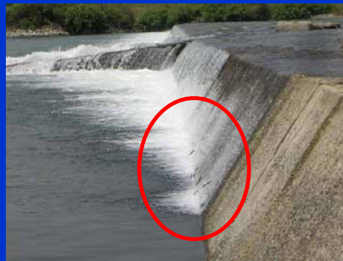
(河口から約55km付近:平成20年5月7日)
