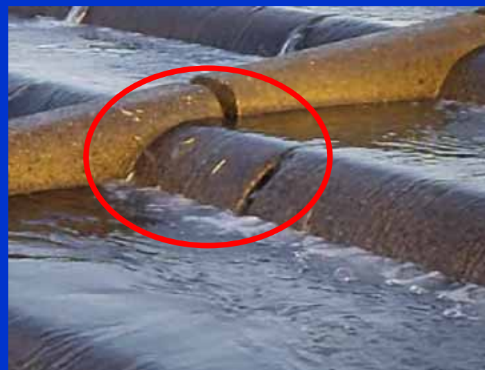
(河口から約50km付近:平成20年5月6日)
