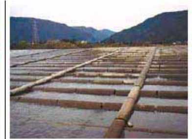
揖斐川第2床固(魚道)
