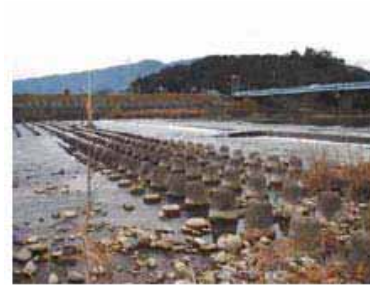
揖斐川第1床固(魚道)
