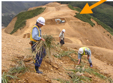
植生回復作業(コア山) 復元した表土を保全するための カヤの利用試験作業
