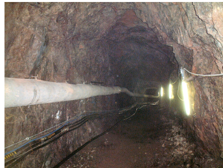
グラウトトンネル坑内
