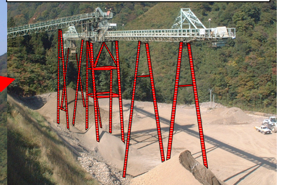
ベルトコンベア支柱の残置
