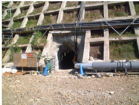
グラウトトンネル坑口
