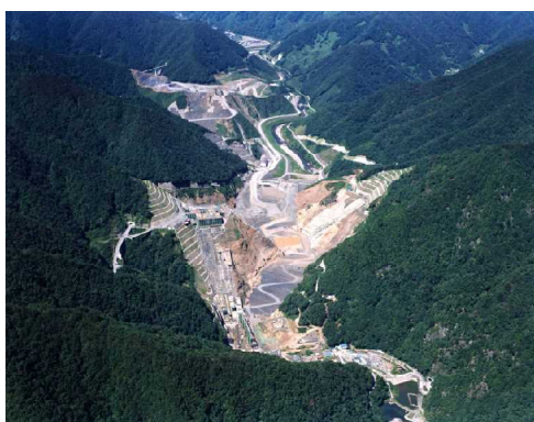
ダムサイト（平成15年9月撮影）
