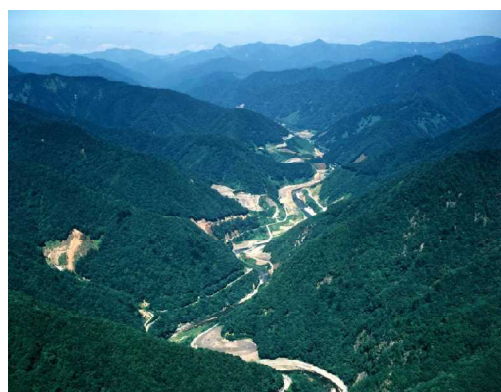
ダムサイト（平成9年8月撮影）
