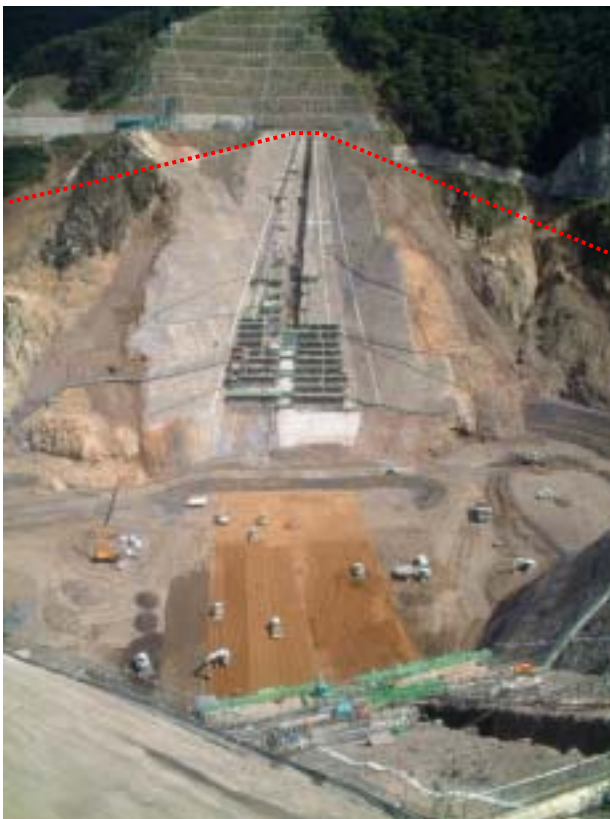
コア・フィルタ盛立状況
