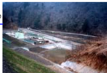
上谷濁水処理施設
