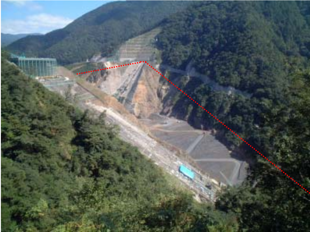
平成 15 年 9 月末現在の状況 堤体下流面・洪水吐き施工状況
