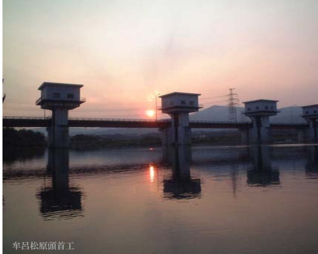
牟呂松原頭首工
