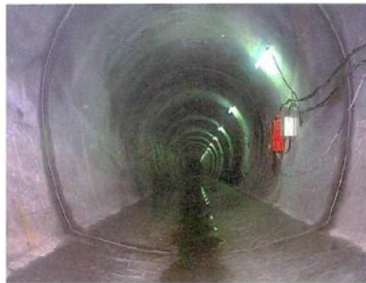
寒狭川導水路
