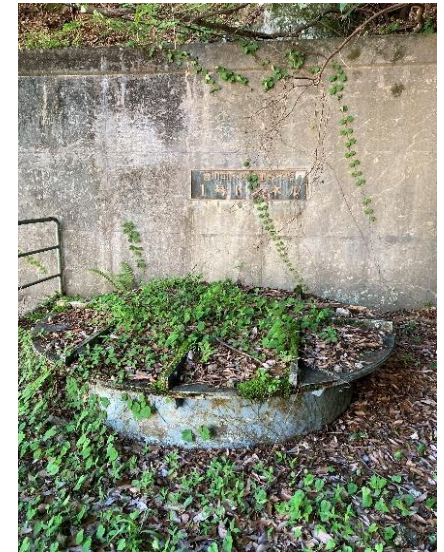
導水路開口部
