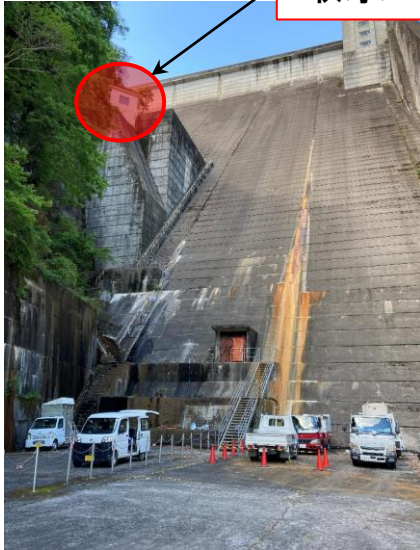
ダム直下流より
