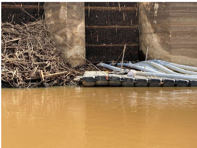
<浮棧橋設置> (既設・宇連)
