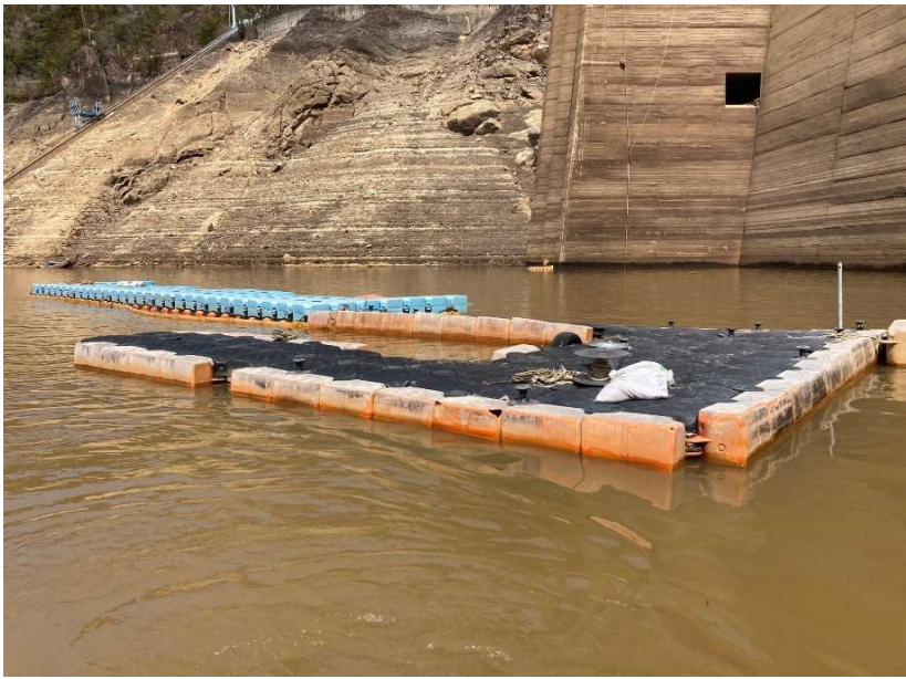
<浮棧橋設置> (既設・宇連)
