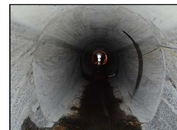
トンネル耐震補強施工前
