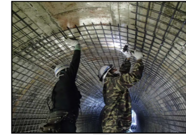
トンネル耐震補強施工中
