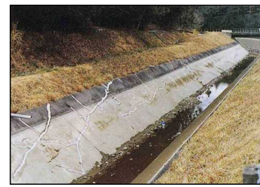
開水路のひびわれ
