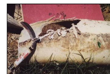
鎌で切断できる老朽化した石綿管
