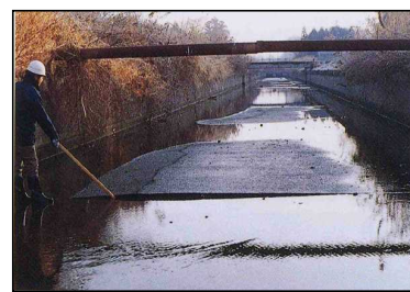
水路底の浮き上がり
