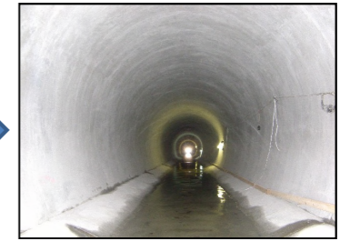
トンネル耐震補強完成
