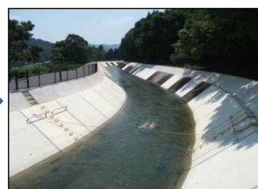
コンクリートライニング打換
