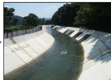
コンクリートライニング打換
