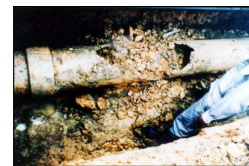
石綿管破損状況
