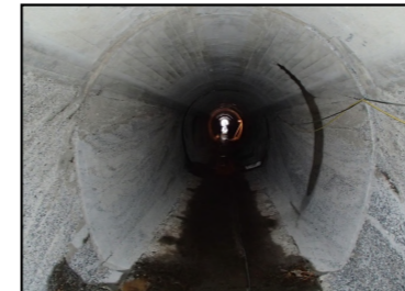
トンネル耐震補強施工前
