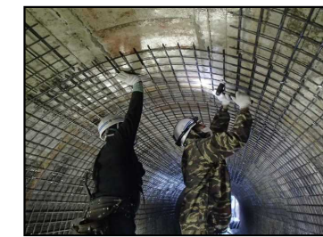
トンネル耐震補強施工中
