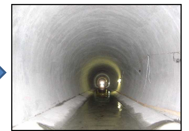
トンネル耐震補強完成
