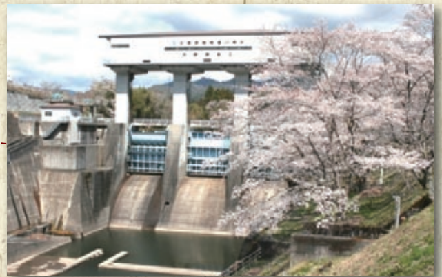
おおのとうしゆこう 大野頭首工 昭和36年完成(平成9年改築) 豊川用水の取り入れ口 ダムからの水を堰上げ幹線水路へと流す
