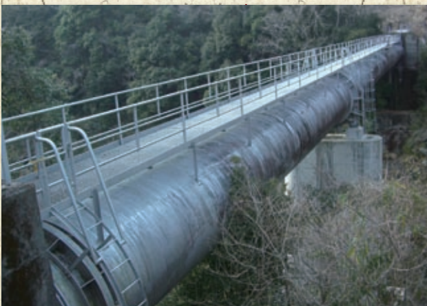
とよがわ 豊川サイホン 昭和43年完成 とうざいぶんすいこう 東西分水工から豊川を渡り新城市、豊川市、蒲都市へと流す
