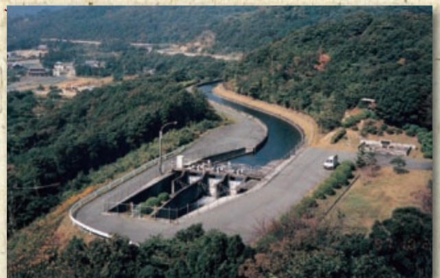
ふたがわ 二川第四開水路と二川チェック 昭和43年完成 豊橋市内東部幹線水路から湖西市と渥美半島へと流す
