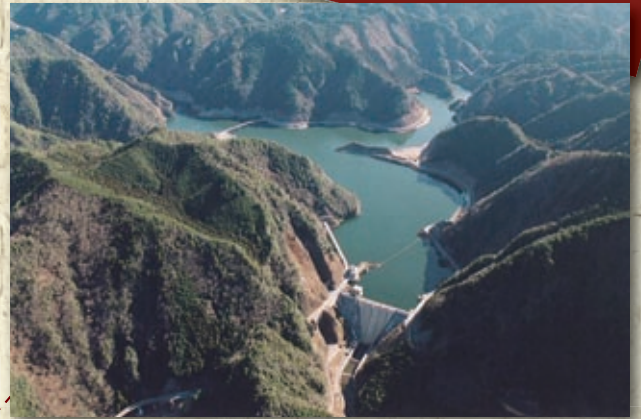
大島ダム（有効貯水量:1,130万m 3 ） 平成13年完成 水不足解消のための新規のダム
