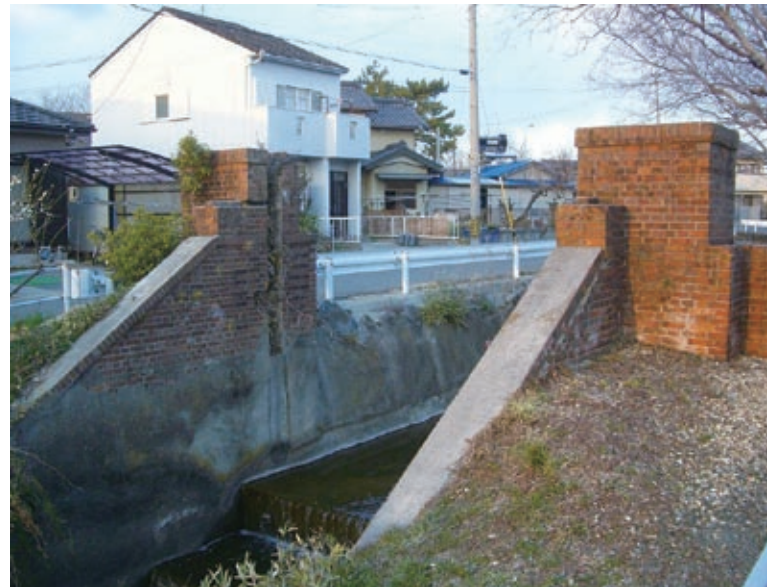
牟呂用水発電所跡
