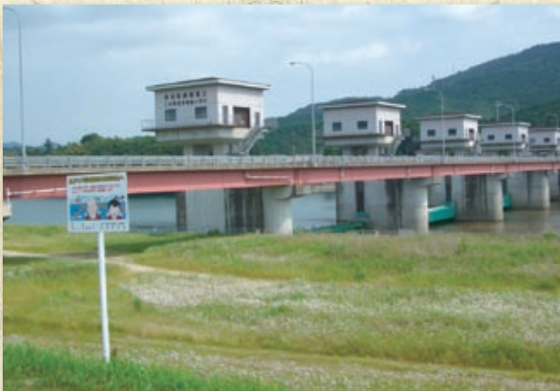
牟呂松原頭首工 牟呂用水、松原用水の堰を合口して昭和 43 年完成(平成 9 年改築)
