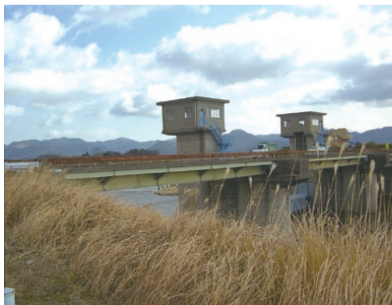
豊川放水路(豊川市行明町、現在)
