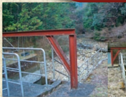
佐久間導水路(出口) 佐久間ダムからの導水は、14.2km先の宇蓮川(うれがわ)の支流・亀淵川(かめぶちがわ)に注がれる。 導水は、毎年5月9日から9月20日の間、一定の条件(天竜川の流量と宇蓮ダム貯水量等規定値)の範囲で可能となる。
