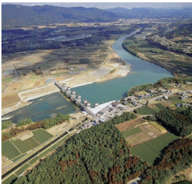
牟呂松原頭首工(上空より撮影、現在)
