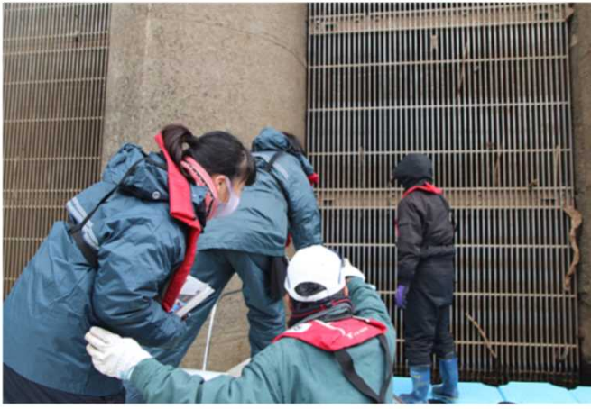
取水設備点検
