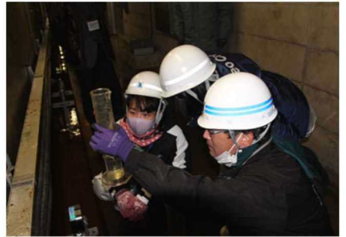
ダム漏水量測定
