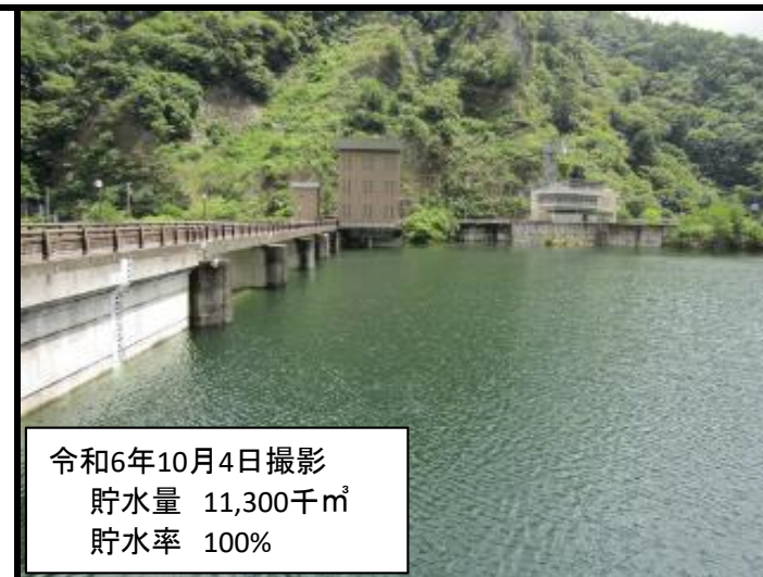
満水時の大島ダム貯水池
