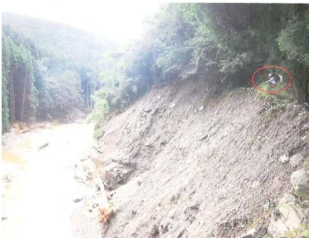
写真一土砂崩れにより道路が崩落
