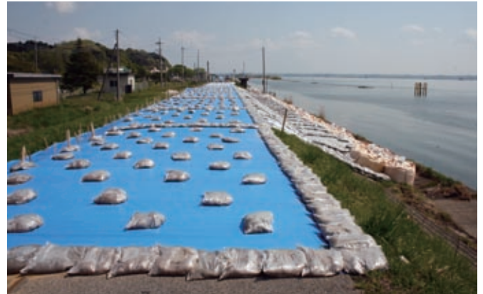
湖岸堤の応急復旧状況
