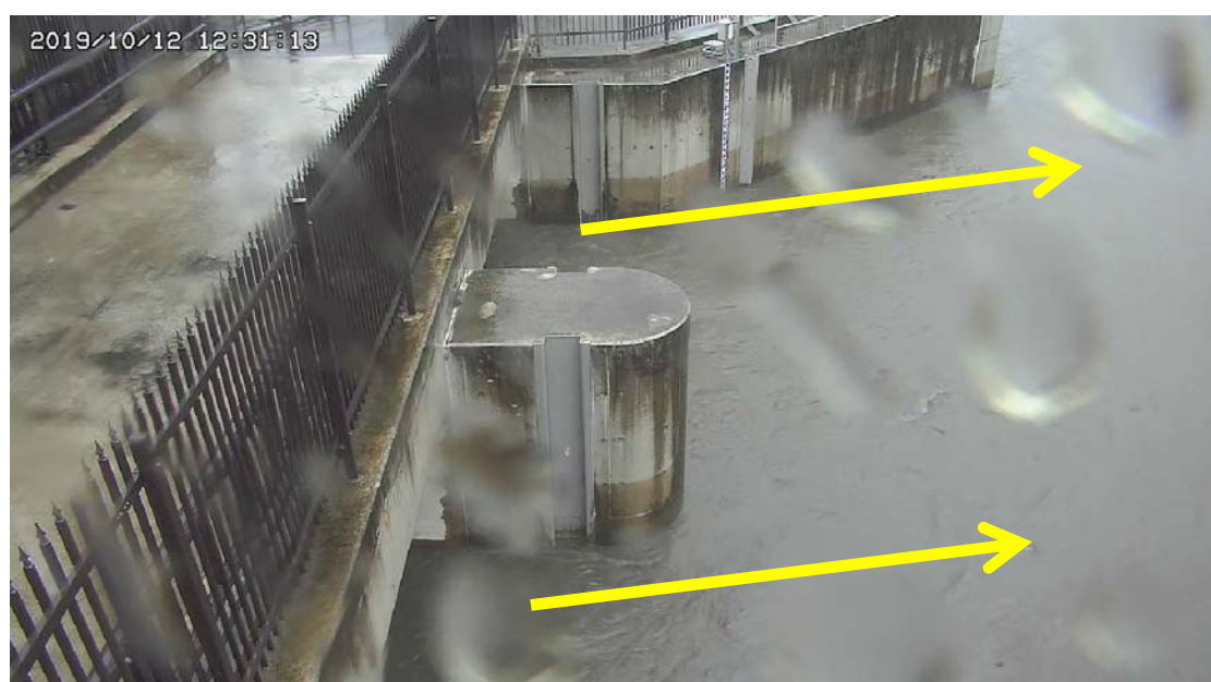
令和元年10月12日 12:31 川面水門 水路側状況
