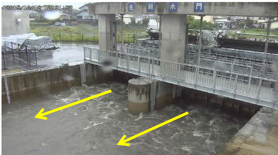
令和元年10月12日 12:31 佐間水門 水路側状況
