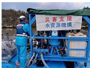
浄水装置の設置を完了
