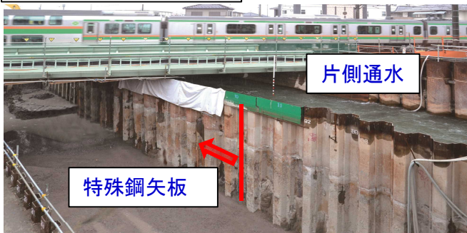
半川締切工 設置完了
