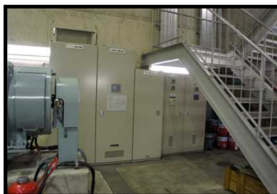
部分更新後の装置
