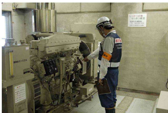
【設備点検等の演習①】
