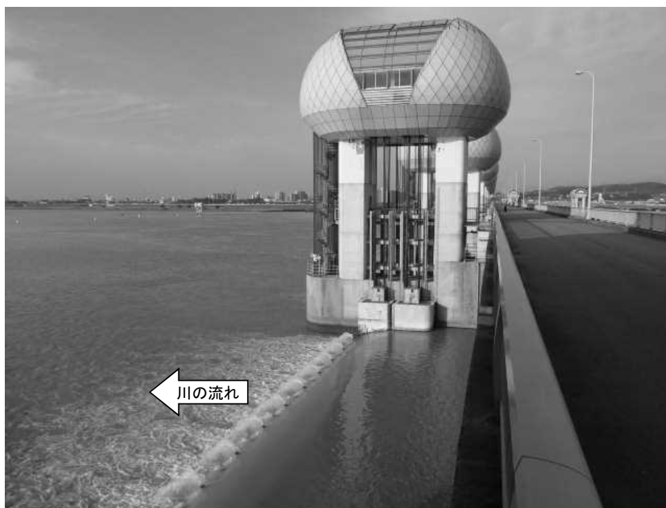
ゲート全開操作終了後の長良川河口堰（オーバーフロー操作に切り替え） 9月6日 7時10分撮影
