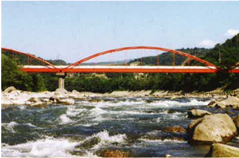
利根川水管橋
