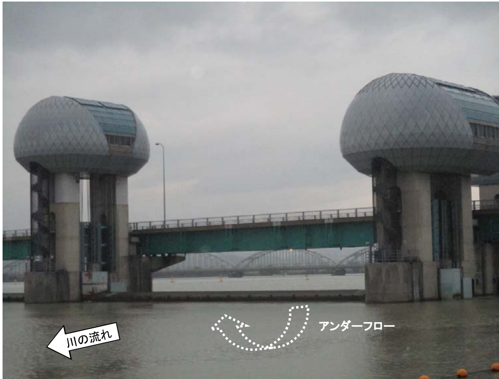
ゲート全開操作終了後の長良川河口堰（アンダーフロー操作に切り替え） 7月2日 7時撮影
