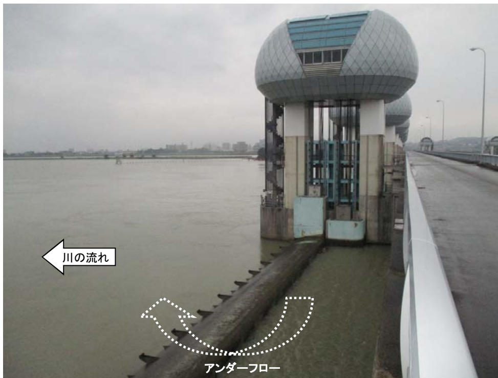
ゲート全開操作終了後の長良川河口堰（アンダーフロー操作に切り替え） 7月2日 7時撮影
