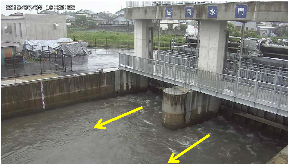
令和元年7月4日 10:35 佐間水門 水路側
