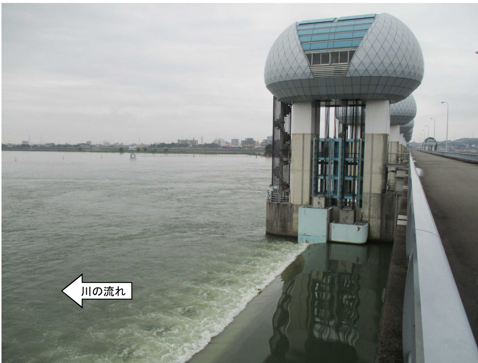
ゲート全開操作終了後の長良川河口堰（オーバーフロー操作に切り替え） 7月21日 7時撮影
