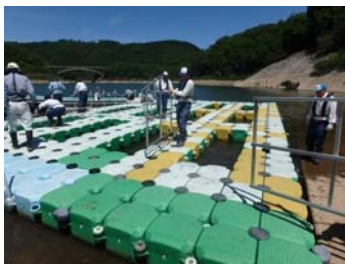
フロート整備
