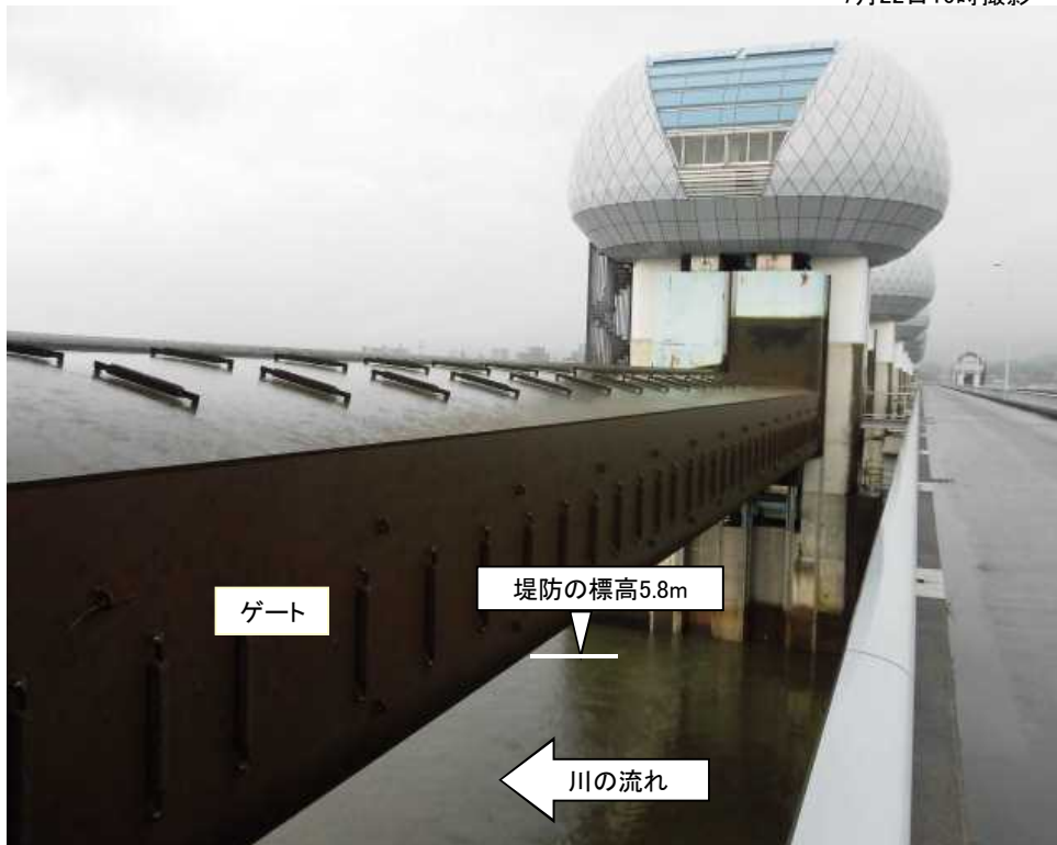
ゲート全開操作開始後の長良川河口堰（堤防より高い位置にゲートを引き上げ）
