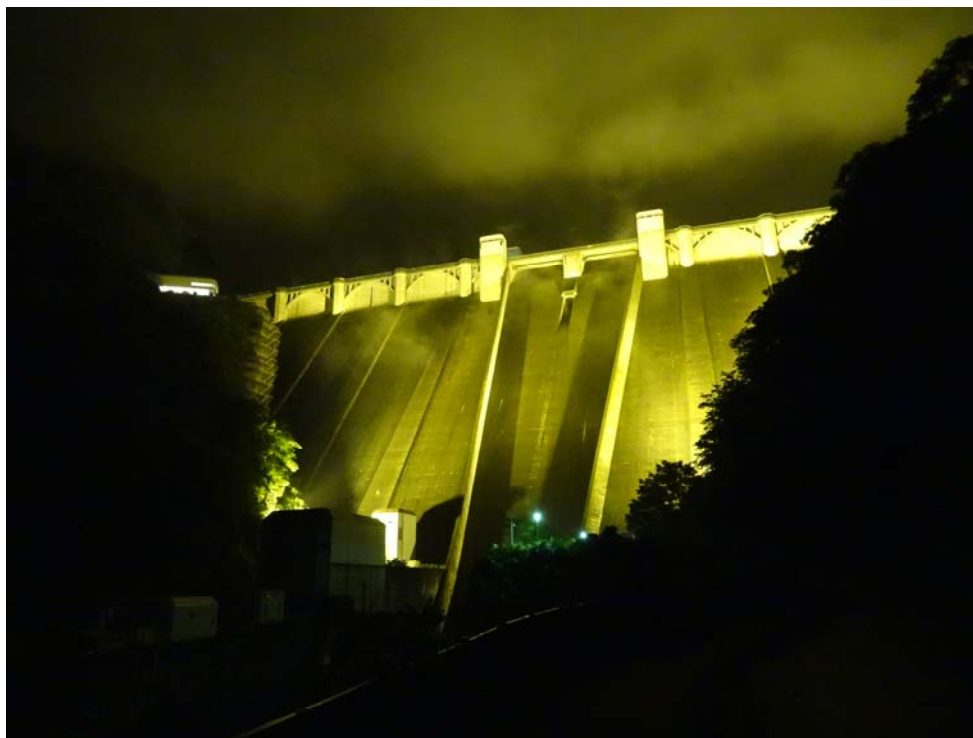
浦山ダム下流から
