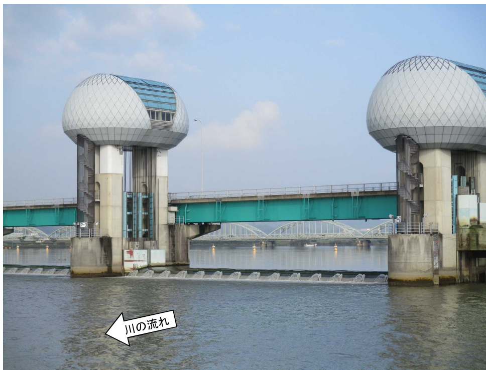
ゲート全開操作終了後の長良川河口堰（オーバーフロー操作に切り替え） 8月24日 7時撮影
