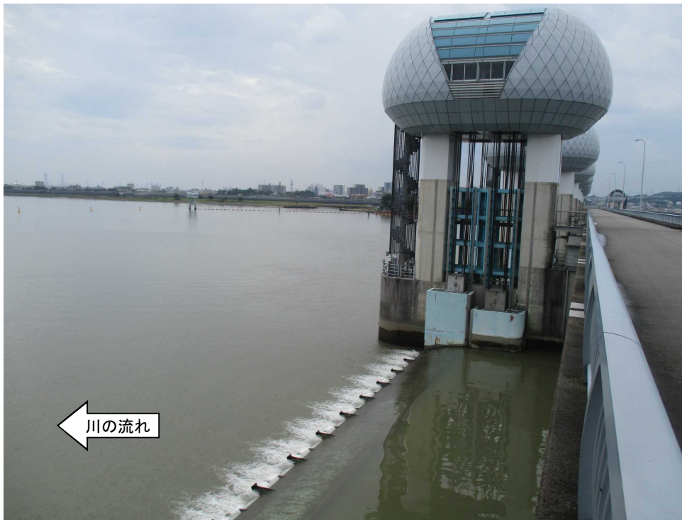
ゲート全開操作終了後の長良川河口堰（オーバーフロー操作に切り替え） 8月31日 12時撮影
