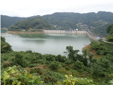
台風前の下久保ダム貯水池
