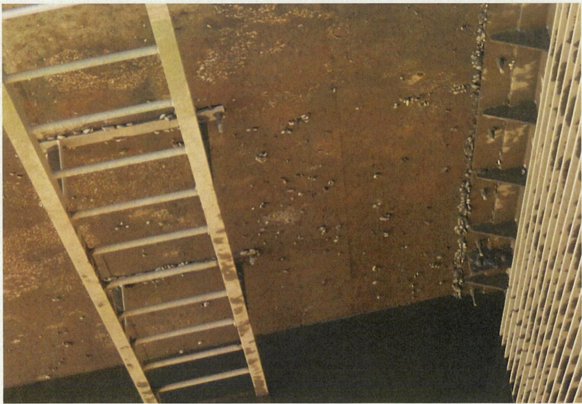
② 送水ポンプゲート前付近の吸水槽壁面に付着したカワヒバリガイの様子 (右側の銅製スクリーンへの付着は皆無)
