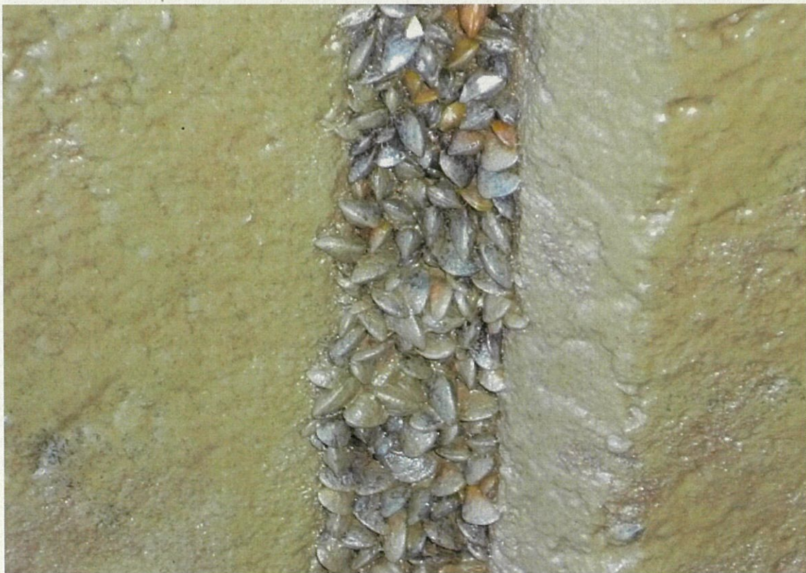
(過去の状況) 平成 28 年度調査時には、大量の付着が確認されました。
