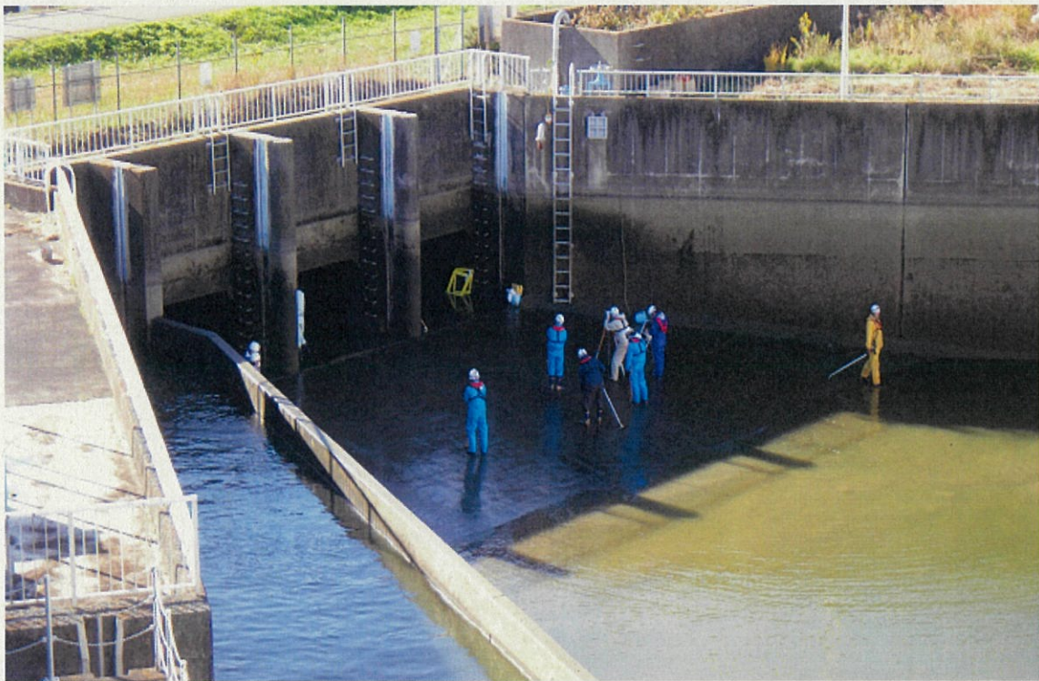
① (左手側) 樋管を空水とするため吸水槽の水位を低下させた上で、沈下状況を測量中
