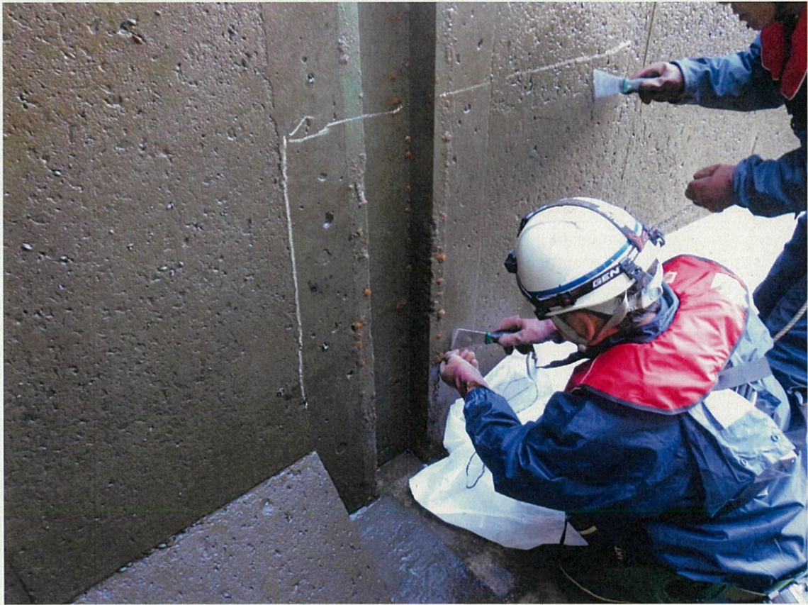
③ 側壁に付着したカワヒバリガイのケレン作業中
