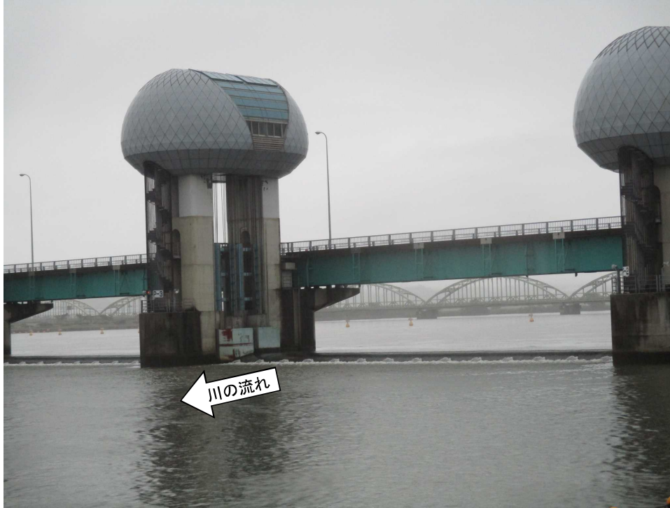
ゲート全開操作終了後の長良川河口堰（オーバーフロー操作に切り替え） （1回目）
