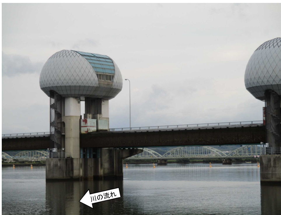
ゲート全開操作開始後の長良川河口堰（堰下流側） （2回目） 6月15日 5時撮影
