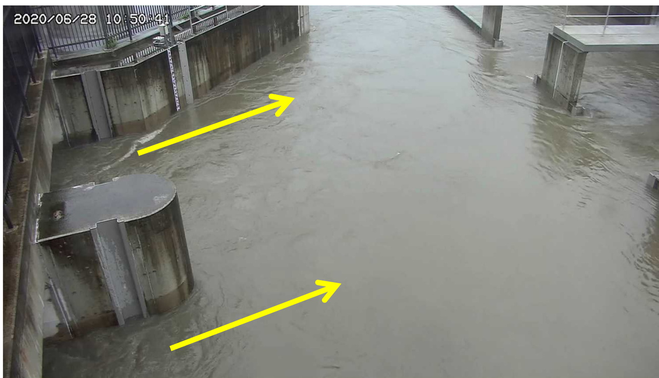
令和2年6月28日 10:50 川面水門 水路側
