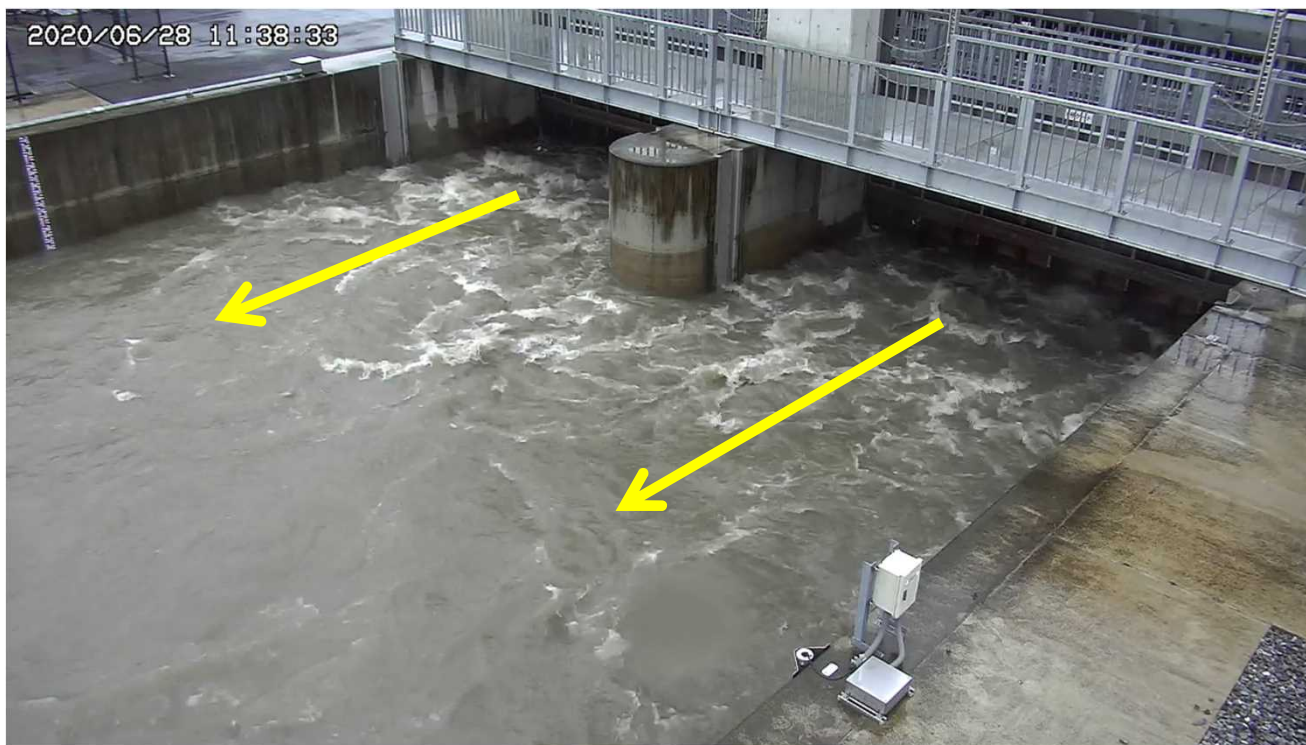
令和2年6月28日 11:38 佐間水門 水路側
