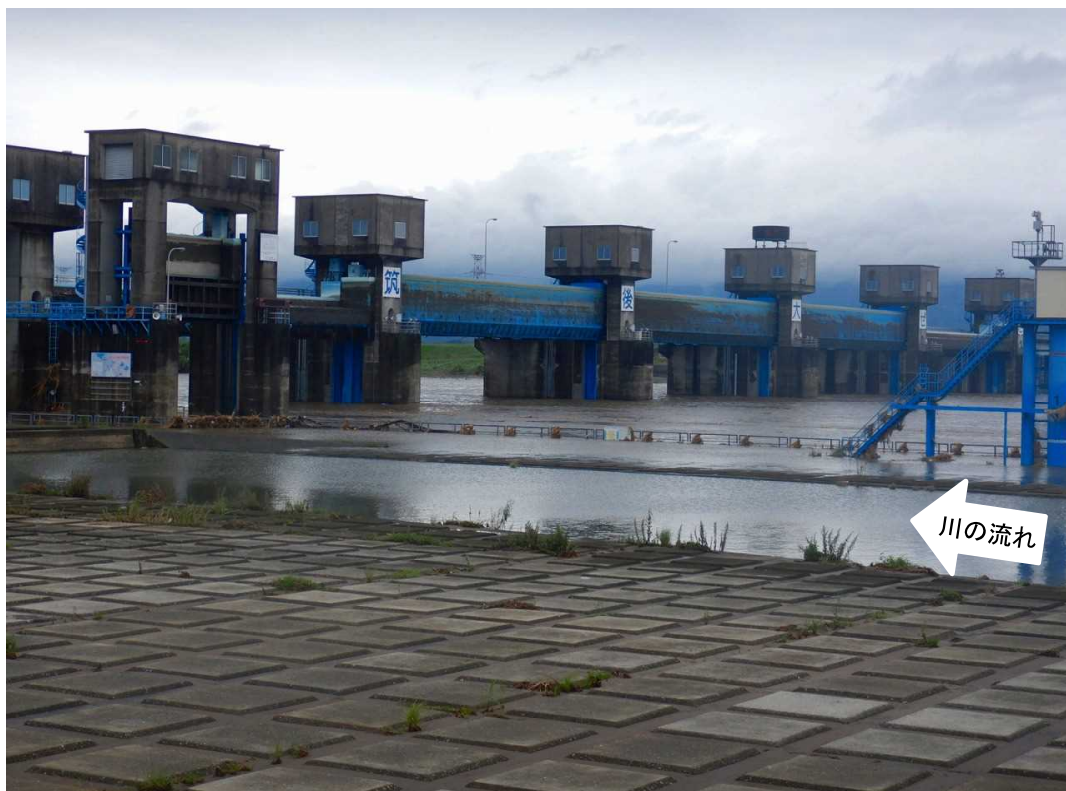
ゲート全開操作開始後の筑後大堰 (左岸堰上流側から堰を望む)
