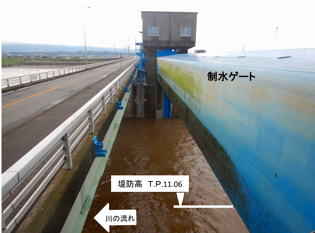
ゲート全開操作開始後の筑後大堰 7月24日12時 撮影 (堤防高と同じ高さ(T.P.11.06m)にゲートを引き上げました。)
