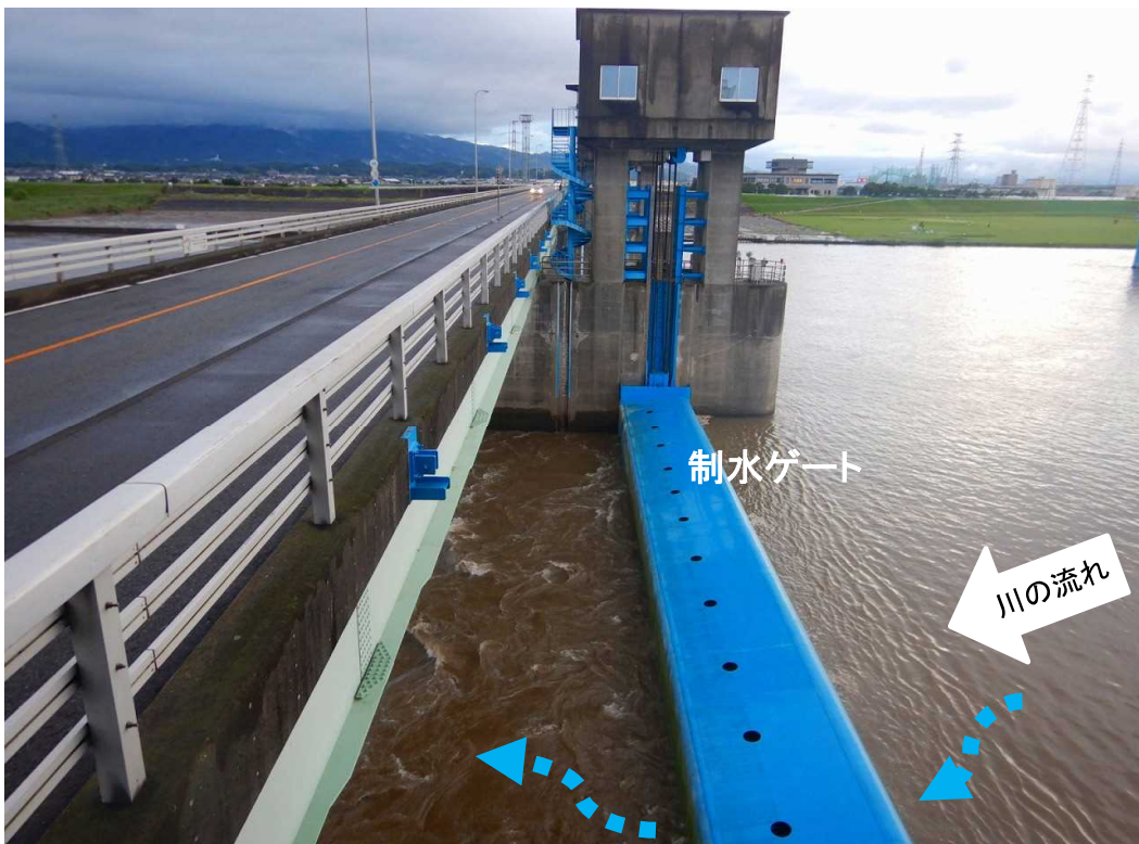
ゲート全開操作終了後の筑後大堰 7月25日6時 撮影 (1号制水ゲートを左岸から右岸に向かって望む)
