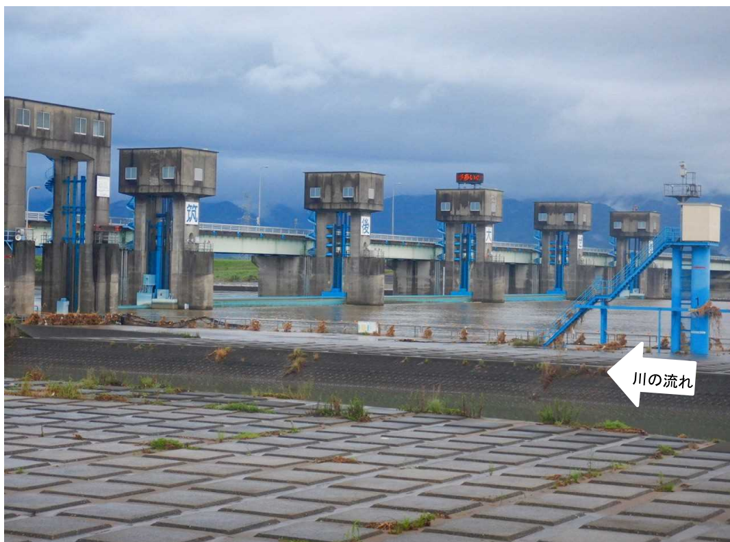
ゲート全開操作終了後の筑後大堰 (左岸堰上流側から堰を望む)
